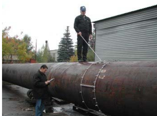
Рис.5. Обследование газонефтепроводов контактным способом.
