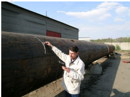
Рис.4. Обследование газонефтепроводов контактным способом.
